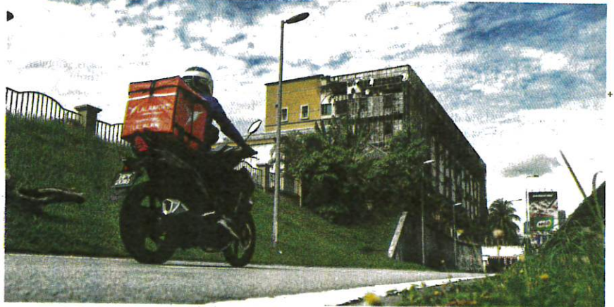
KEADAAN terkini bangunan lama Kumpulan Wang Simpanan Pekerja (KWSP) di Jalan Gasing, Petaling Jaya yang terbakar buat kali kedua selepas insiden sama pada 2018. Penolong Operasi Jabatan Bomba dan Penyelamat Selangor Hafisham Mohd Noor berkata, kebakaran hanya melibatkan tingkat empat dan tingkat lima bangunan itu. Tiada sebarang kemalangan jiwa dan punca kebakaran masih dalam siasatan.
