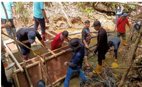
Imej 6.20 Pembinaan Sistem Bekalan Air Paip Gravity di Kampung Kahaba, Keningau, Sabah
